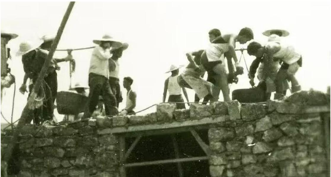
图 1-3 浇灌混凝土楼板
